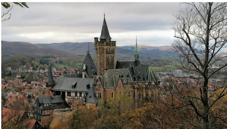
Herbstlicher Blick vom Agnesberg auf Schloß Wernigerode. Die erneuerten Schornsteinköpfe sind deutlich zu erkennen. (Foto E. Schröder)
