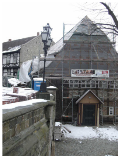
Am 25. März 2008 - eine typische Winterbaustelle
