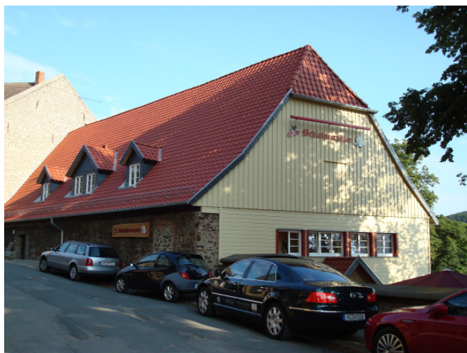
Gaststätte „Schlossterrassen“ - Nach der Fertigstellung im Juli 2008
